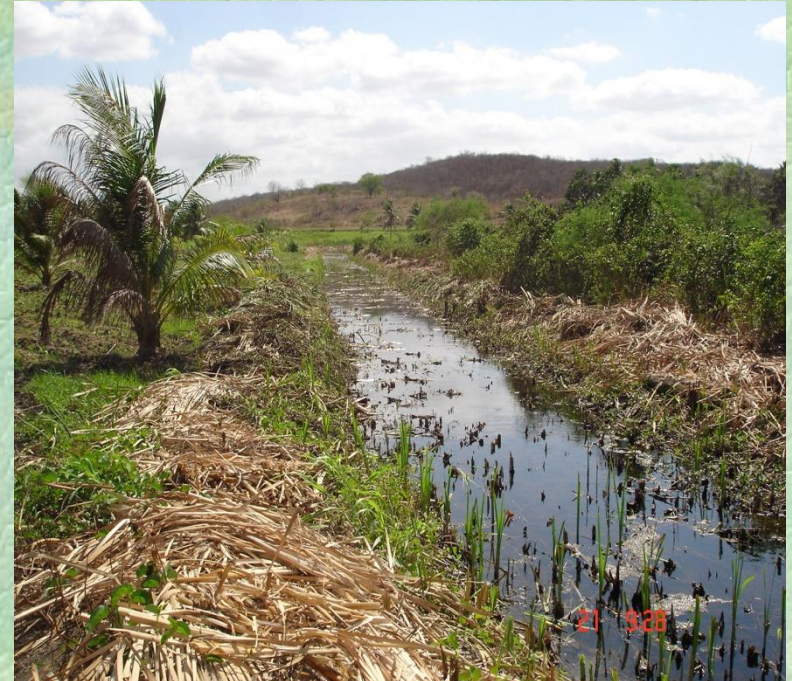
•Coletor após a limpeza (fonte de descarga)
