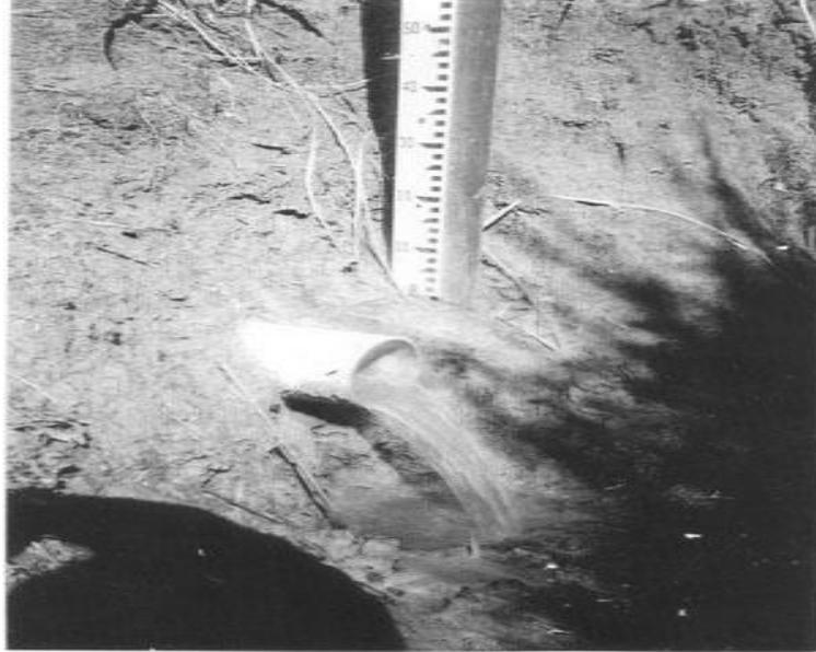
Dreno lateral subterrâneo com descarga para um canal coletor.
