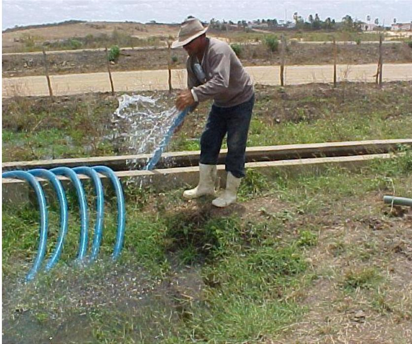
**Figura 02.** Procedimento de escorva para funcionamento dos sifões.
