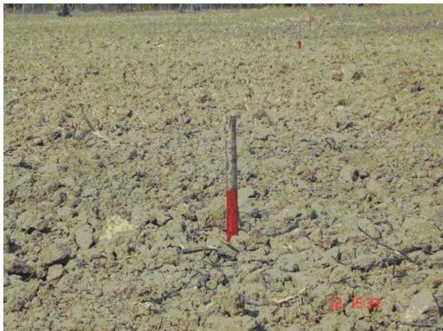
**Fig. 10.** Estaca marcando altura de corte.
