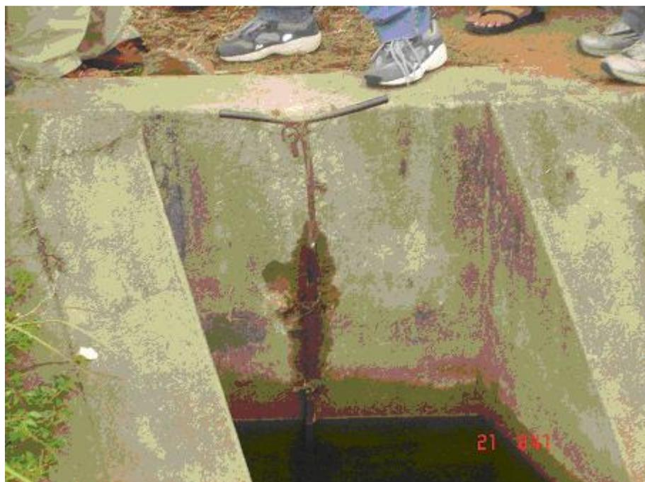
**Fig. 3.** Estrutura para derivação de água em canais
